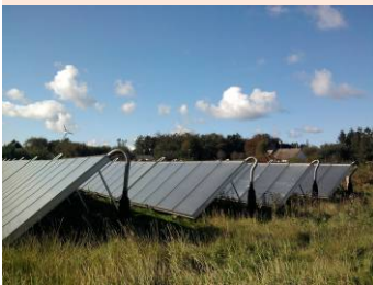
Εικόνα 26 Σύστημα τηλεθέρμανσης μικρής κοινότητας (Samsøe Δανίας) με ηλιακά πλαίσια και βιομάζα
