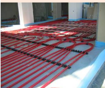
Εικόνα 15. Εργασίες τοποθέτησης κυκλώματος ζεστού νερού για υποδαπέδια θέρμανση.
