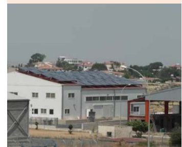
Εικόνα 20. Εγκατάσταση ηλιακού κλιματισμού - Αρτοποιείο L' Amor Rouge
