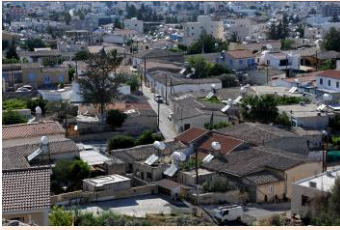
Εικόνα 4. Θερμικά ηλιακά συστήματα εγκατεστημένα σε οροφές κτιρίων στην Κύπρο Φώτο: Κωνσταντίνος Χαραλάμπος
