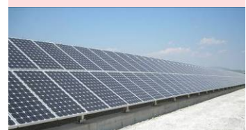
Εικόνα 20. Φωτοβολταϊκά πλαίσια στερεωμένα στο έδαφος
