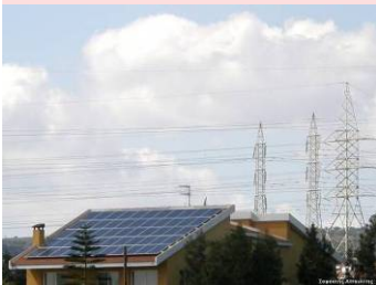
Εικόνα 3. Εφαρμογή Φωτοβολταϊκού συστήματος σε οροφή κατοικίας Φώτο: Σοφοκλής Αύπαυλιτης
