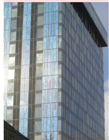
Εικόνα 19. Φωτοβολταϊκά στην πρόσοψη κτιρίου (Λινζ-Αυστρία)
