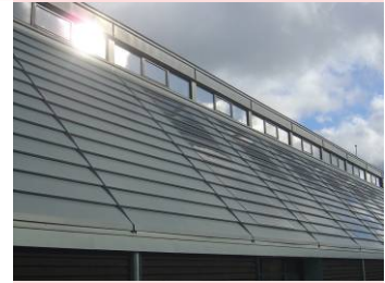
Εικόνα 17. Φωτοβολταϊκά στερεωμένα ενσωματωμένα σε οροφή (Samso-Δανία)
