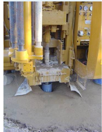
Εικόνα 12. Ανόρυξη γεώτρησης κατακόρυφου γεωθερμικού κυκλώματος
