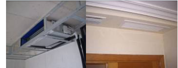
Εικόνα 11. Σύστημα ψύξης με fan coils κατά τη φάση κατασκευής και μετά την ολοκλήρωση
