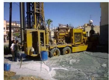
Εικόνα 13. Παραγωγή λάσπης κατά την ανόρυξη γεώτρησης
