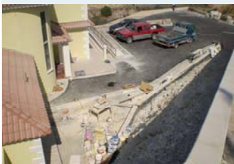
Εικόνα 16. Το Γεωθερμικό κύκλωμα μετά την ολοκλήρωση της οικίας (δεν είναι ορατό).
