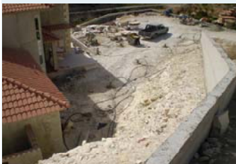
Εικόνα 15. Το Γεωθερμικό κύκλωμα (5 γεωτρήσεις) κατά τη φάση κατασκευής της οικίας.
