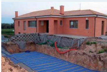
Εικόνα 8. Εγκατάσταση οριζόντιου Γεωθερμικού κυκλώματος
