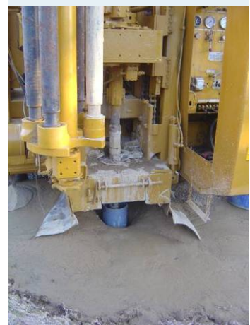
Εικόνα 12. Ανόρυξη γεώτρησης κατακόρυφου γεωθερμικού κυκλώματος
