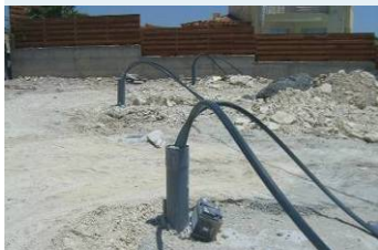
Εικόνα 6 Εγκατάσταση κατακόρυφου Γεωθερμικού κυκλώματος
