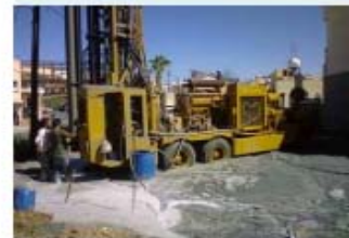
13. Παραγωγή λάσπης κατά την ανόρυξη γεώτρησης
