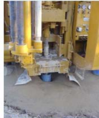
2. Ανόρυξη γεώτρησης κατακόρυφου γεωθερμικού κύκλωματος
