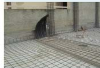
Το Γεωθερμικό κύκλωμα
